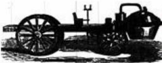
Imagine só: um trator de três rodas, movido a vapor, que era usado para arrastar canhão. A velocidade? Ele andava a, aproximadamente, 4 km por hora. O trator não conseguia rodar muitos metros de uma vez. Ele tinha de parar para acumular vapor. Só então, voltava a funcionar.
