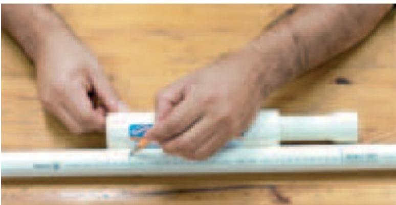
Aplice o Adesivo Aquatherm® nas bolsas da Junta de Expansão e instale-a no trecho da tubulação horizontal ou vertical.
