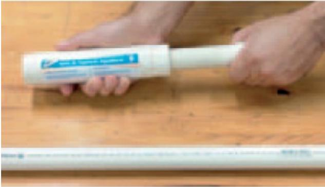
A Junta de Expansão Aquatherm® deve ser instalada com o pistão parcialmente estendido. Faça a marcação do comprimento de acordo com a tabela abaixo.
