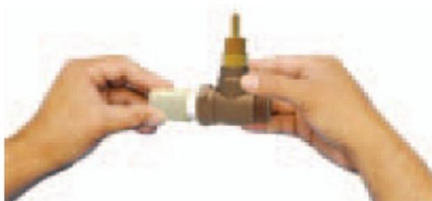
**Instalação da Junta de Expansão:** a junta de expansão serve para absorver variações do comprimento dos tubos (dilatação e contração) provocadas por variações de temperatura, minimizando tensionamentos causados pela transmissão de esforços ao sistema de tubos e conexões. É instalada entre pontos fixos e retilíneos da tubulação de água quente.
