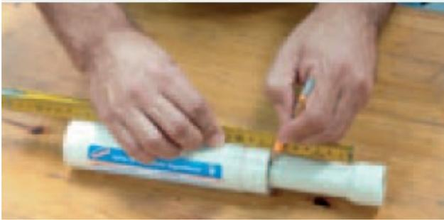
Posicione a Junta de Expansão com o pistão devidamente estendido no local onde será instalada. Faça as marcações de corte da tubulação nos locais coincidentes com o fundo das bolsas da Junta de Expansão.
