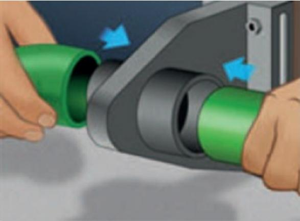
Passo 6: Retire o tubo e a conexão da termofusora após passado o tempo mínimo determinado para a fusão, conforme tabela logo após o término do passo a passo.
