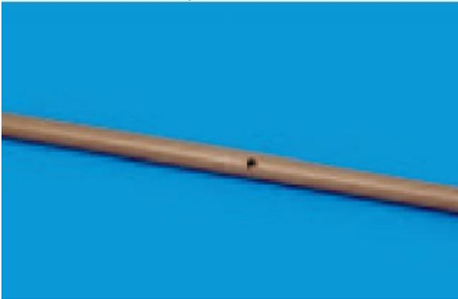
**Passo 2:** Corte o local danificado e substitua por um novo trecho de tubo.
